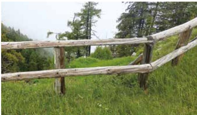
*Barriera per bestiame con struttura e corso superiore in tondi e corso inferiore in mezzi tondi*
