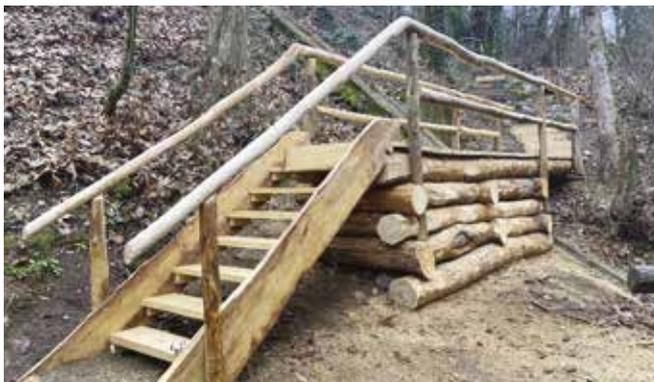
Scala sospesa realizzata con travi in legno di castagno, con scalini inseriti tra i due longaroni
