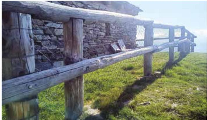
*Barriera con struttura portante e traverse in semitondi*
